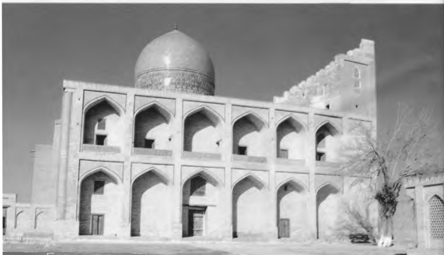
Хонақоҳ фасади. Таъмирдан кейинги кўриниши.
